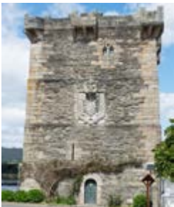
Turm in Ponteume
