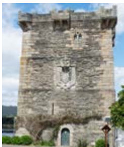
Turm in Ponteume
